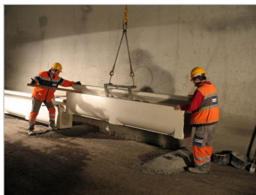
Figure 5: a) Exemple d'un caniveau fendu b) Foto d'un caniveau fendu c) Pose d'un caniveau fendu
